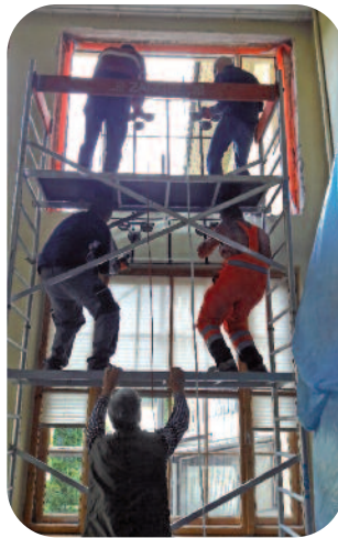
Het inbouwen van de nieuwe ramen was een echt meesterwerk
